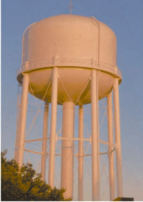
Sistemi e componenti per l'acqua potabile
