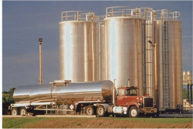
Sostanze chimiche per il trattamento dell'acqua potabile
